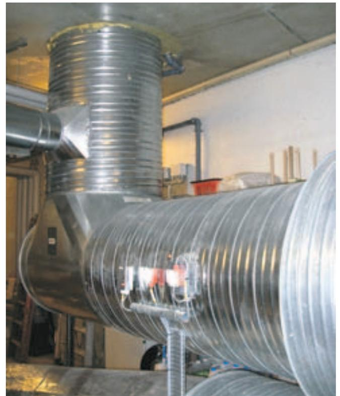
Multihallen er bygget direkte over bunkerens, og store rør, der er ført gennem de op til 2 meter tykke betonvægge, sørger for ind- og blæsning. Luften i bunkerens ligger nogenlunde konstant på 12 grader
